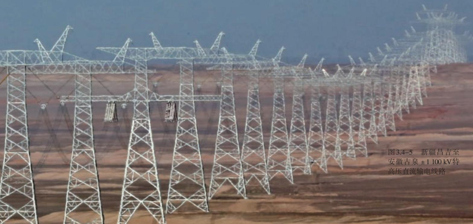
图 3.4-5 新疆昌吉至安徽古泉 ±1 100 kV 特高压直流输电线路
